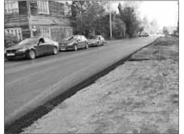
■ На ул. Октябрьской ремонтируют дорогу
