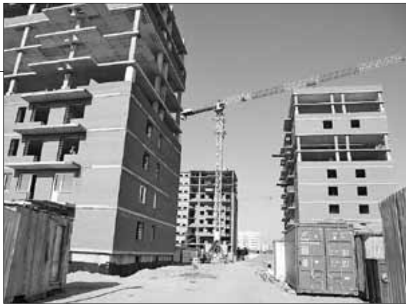
■ Новостройки на Ленинградском проспекте
