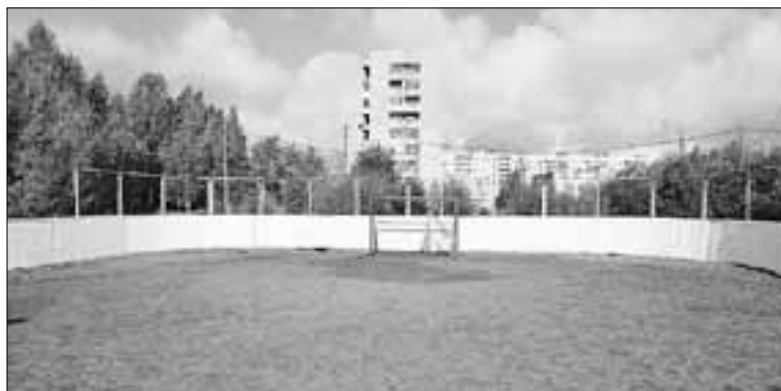
■ Ограждение футбольно-хоккейного корта было отремонтировано и покрашено, благоустройство продолжится
